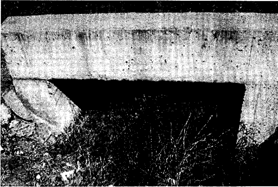
Fotografía 1.5-3 Entrada Oriente de Obra de Arte N°2
