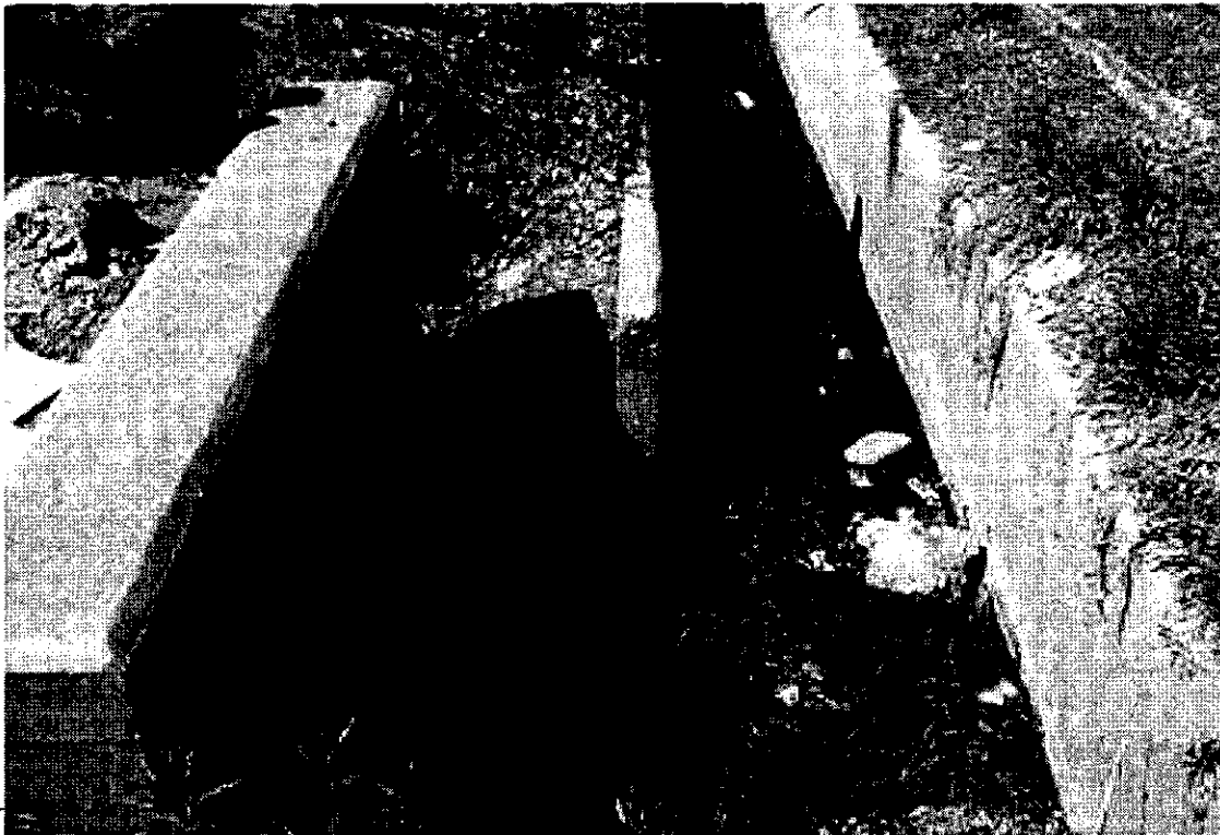
Fotografía 1.5-4 Salida Poniente de Obra de Arte N°2, con Canal Revestido.
