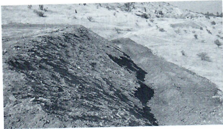
Preparación base de apoyo terraplén
