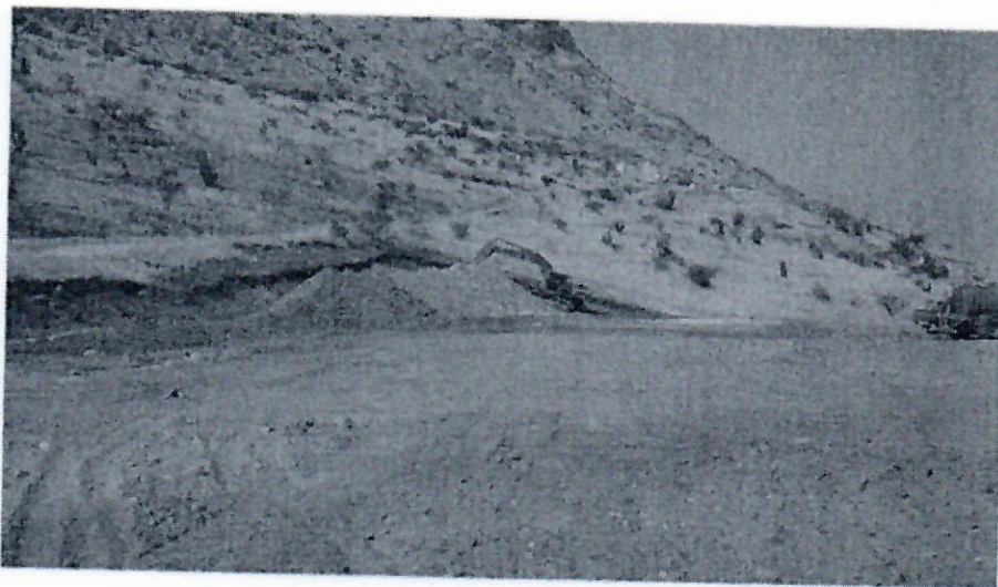
Excavación y retiro de material inadecuado
